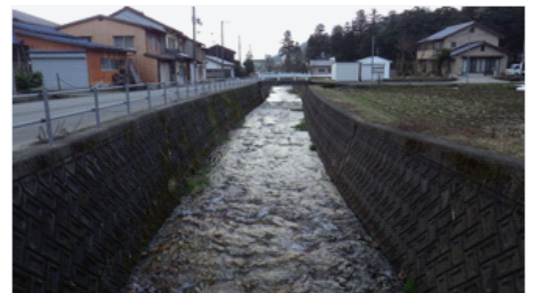
写真1 改修された直線河道
