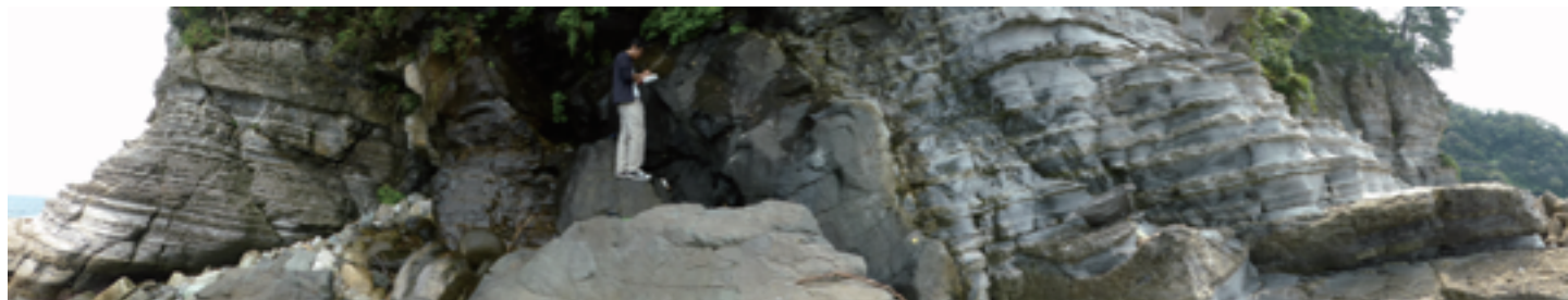
香美町余部の地層を貫く岩脈の調査風景
