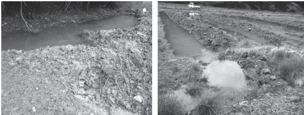
図2. 山裾湛水池の排水をパイプで調整した様子(左)と右方の水路から取水し、棚田状の湿地を連続で造成した様子(右)。後者では調整板の設置が課題。
